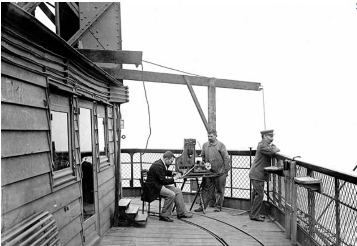
5 Novembre 1898 - Eugène Ducretet établi une liaison radio entre la Tour Eiffel et le Panthéon. On peut voir l'enregistreur à bande de papier.
